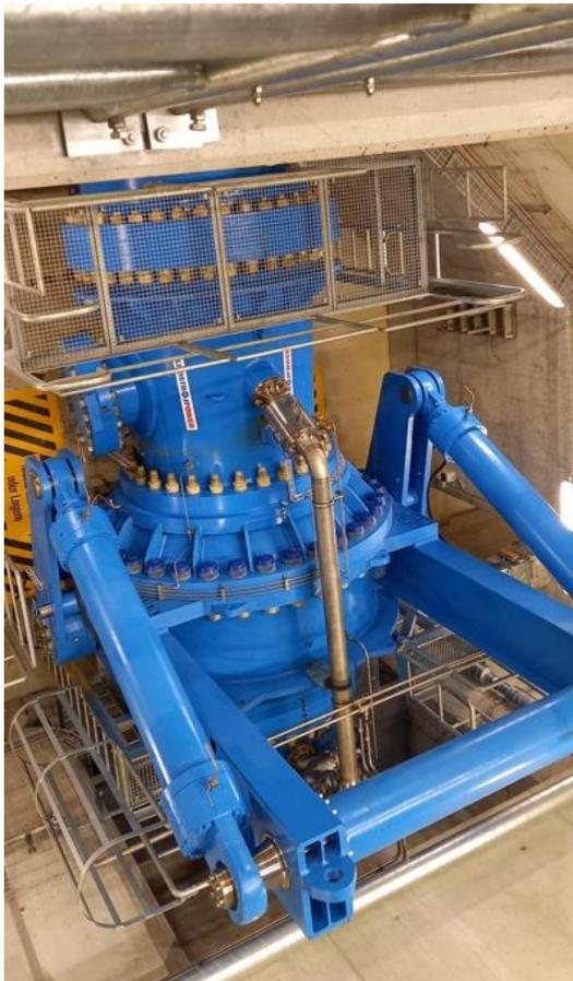
Auf einer Ventilfläche von 2 m Durchmesser lastet ein Druck von 50 bar bei 500 m Fallhöhe aus den Staueeen.
